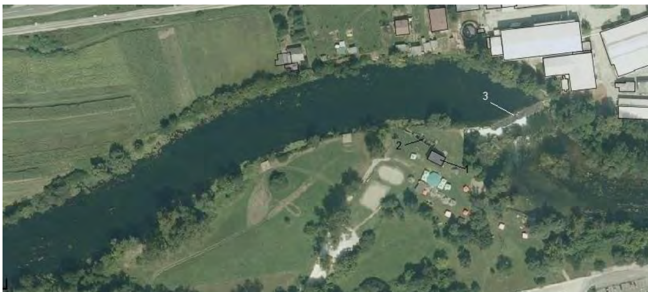
Slika 1.1.-1. Promatrana pozicija sa starom pumpnom stanicom na orto-foto snimci s označenim objektima: 1. stara pumpna stanica, 2. privodni kanal vode u pumpnu stanicu, 3. brana.
