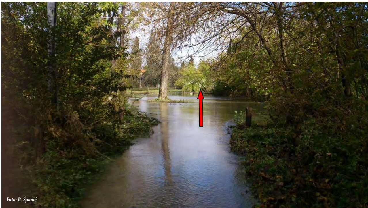
Slika 3.1-6. Pogled na građevinu pumpne stanice sa početka pristupnog puta
