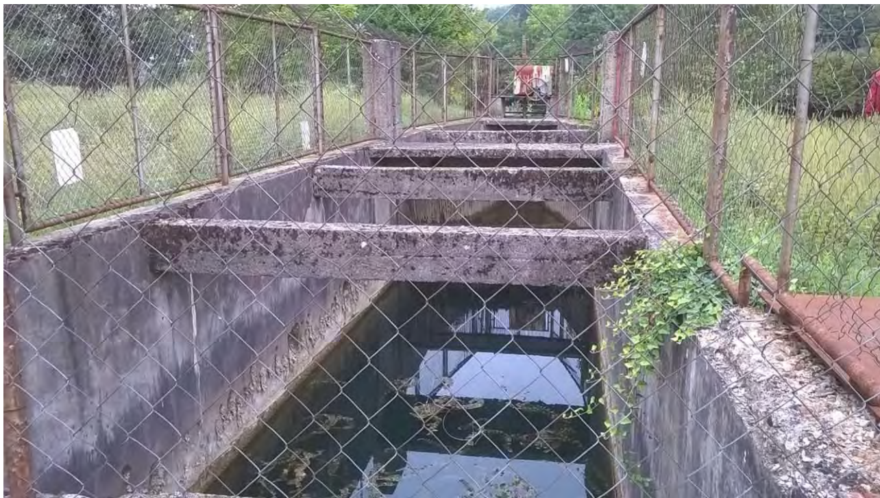
Slika 1.1.-2. Izgled i stanje privodnog kanala.
