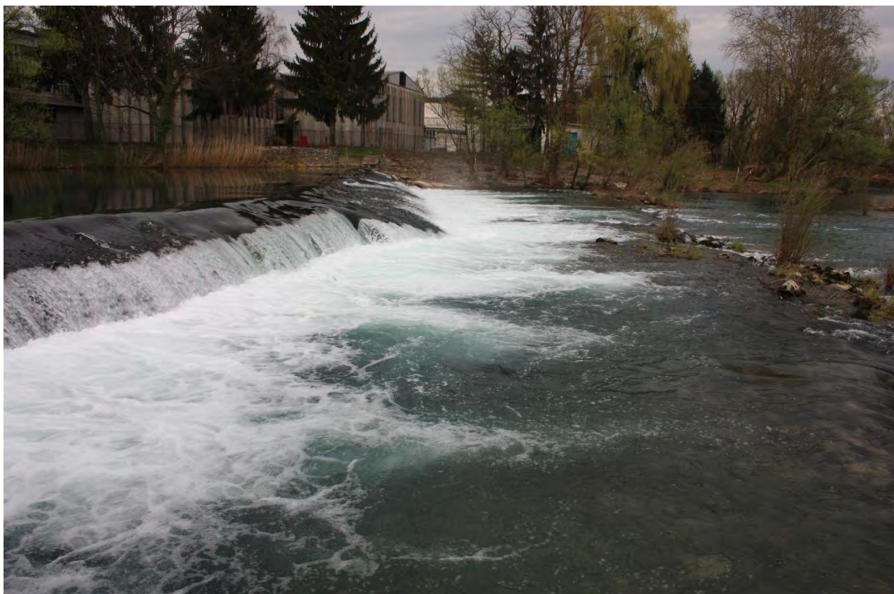
Slika 1.1.-3. Postojeće stanje na brani.
