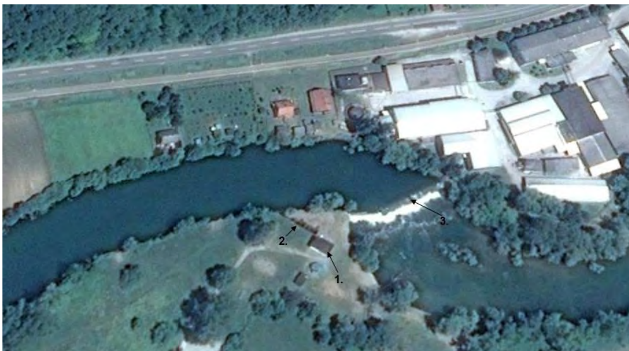
Slika 2.1-1. Orto-foto snimka lokacije s označenim objektima: 1. stara pumpna stanica, 2. privodni kanal vode u pumpnu stanicu, 3. brana.
